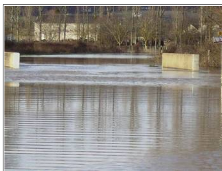
Crue de la Vienne à l'Île-Bouchard (RD221) le 3 mars 2007
