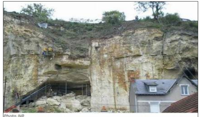
Effondrement du coteau de la Lanterne – 30 avril 2010
