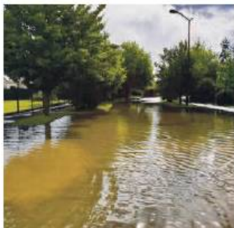
SAINT-CYR-SUR-LOIRE. Un « étang » s'est formé rue du Marquis de Racan. On ne distingue ni la chaussée, ni les trottoirs.
